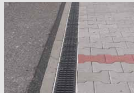
Žlaby MEARIN z vysokopevnostního materiálu SMC MEARIN 100-150-200-300
