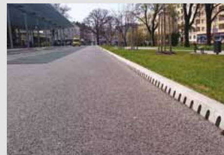
Obrubníkové odvodnění RONN KERB z recyklovaného kompozitu nebo polymerického betonu EK 305-355-480
