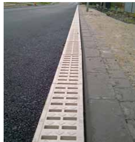
Monolitický žlab DM zvlášť pevné konstrukce pro třídy zatížení až F900 kN.
