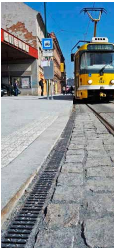
Žlab MEARIN z vysokopevnostního SMC materiálu pro městské komunikace
