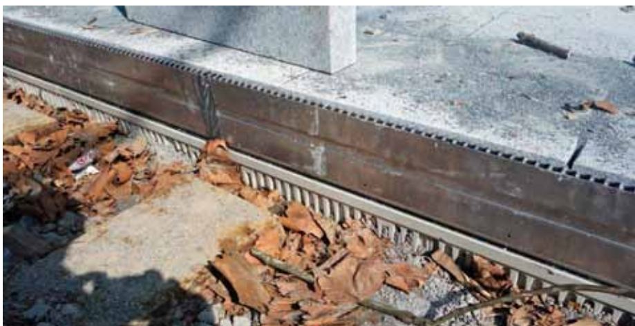
Žlab TSH snese navzdory svému úzkému rozměru zatížení až E600 kN
