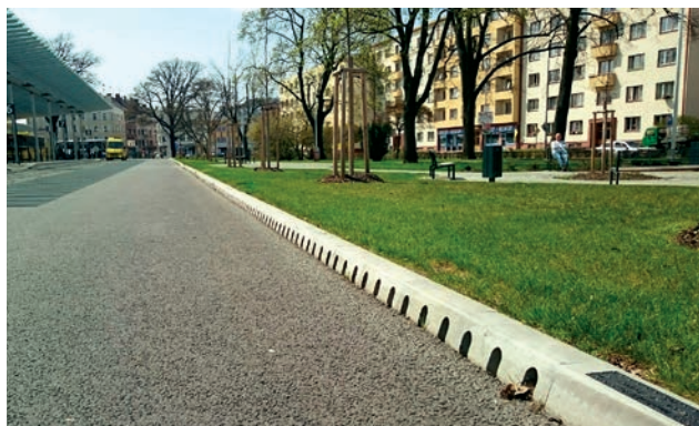
Obrubníkové odvodnění na autobusovém nádraží v Náchodě. Systém MEA KERB využívá obrubníku jako architektonického i funkčního prvku pro rychlé svedení vody z vozovky.
