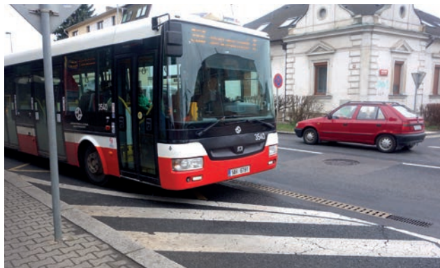
Monolitický žlab z polymerického betonu MEA DM v Praze, Uhřetíněvsi
