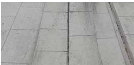
Nejčastěji používané standardní ocelové štěrbinové MEA TSH pro architektonicky náročné plochy s profesionálním žlabem z polymerického betonu nebo SMC kompozitu (Meadrain/ Mearin)
