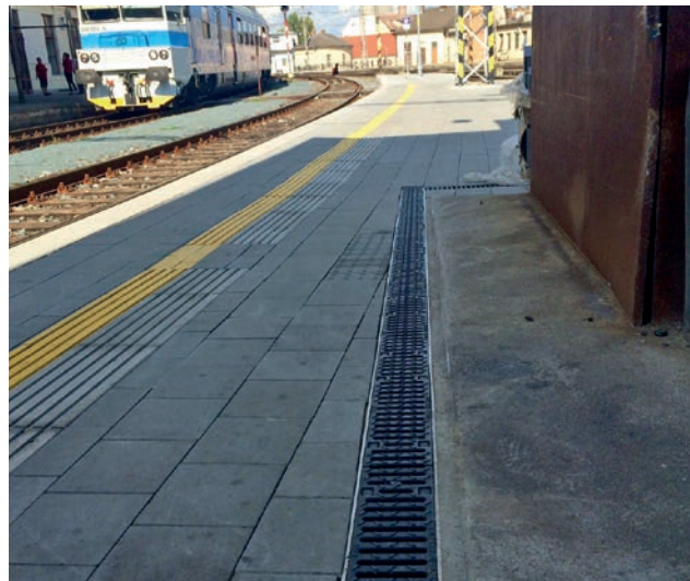
Sklolaminátové žlaby MEARIN 100 na nástupišti v Brně
