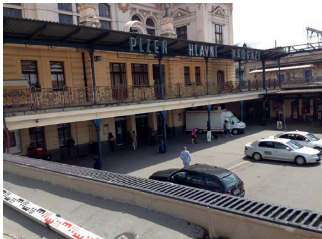
Polymernetonové žlaby RONN TL1000 na plzeňském hlavním nádraží
