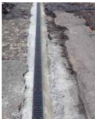
Uložení odvodňovacího systému v betonovém loži
