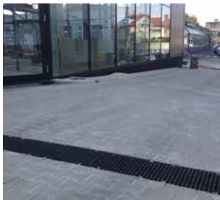
Příčné odvodnění plochy se žlabem MEARIN 200
