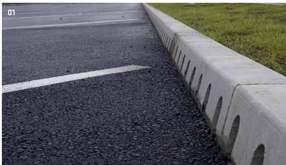
01 &gt; Liniové odvodnění bez omezení šíře vozovky
