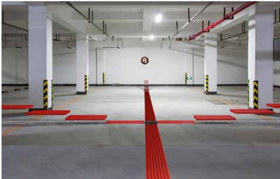
Nové řešení svedení úkapové vody z garážových parkovacích stání, nástupišť a krytých shromažďovacích, pojezdových ploch nabízí jen 30 mm vysoký kompozitní odpařovací žlab MEA PG EVO.
