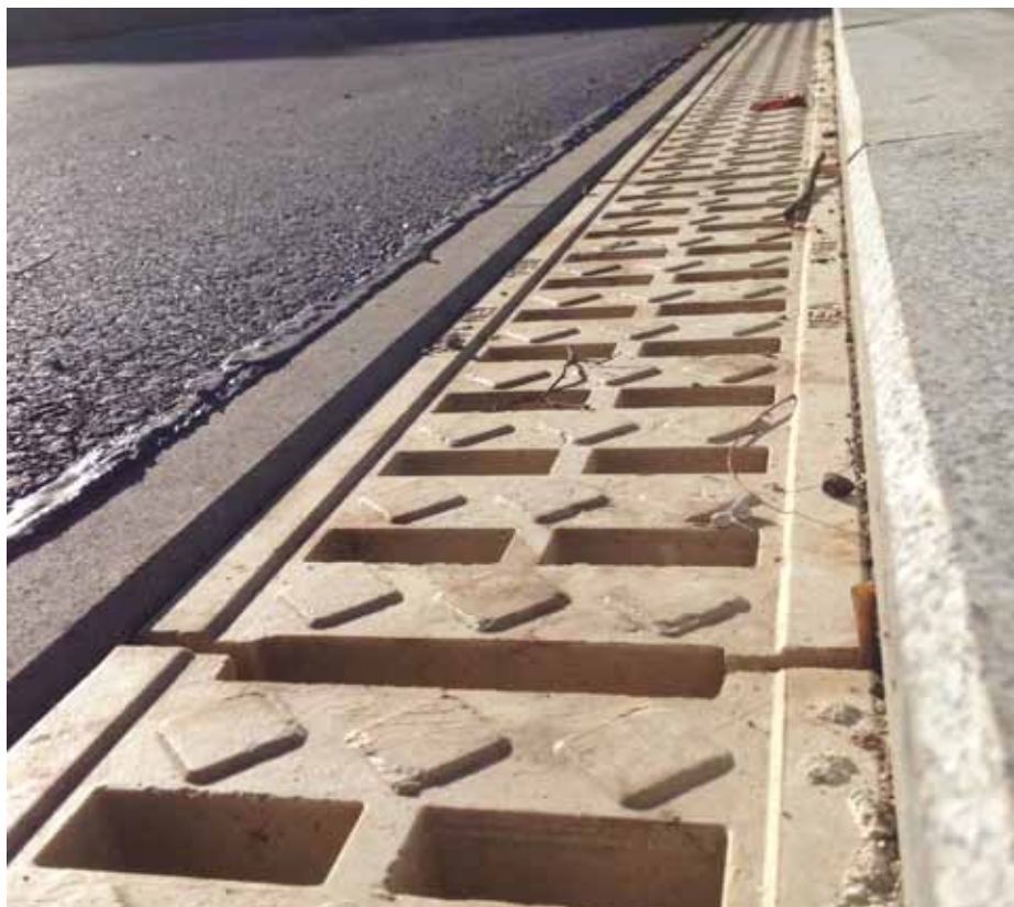
MEA DM: detail roštu polymerického žlabu
