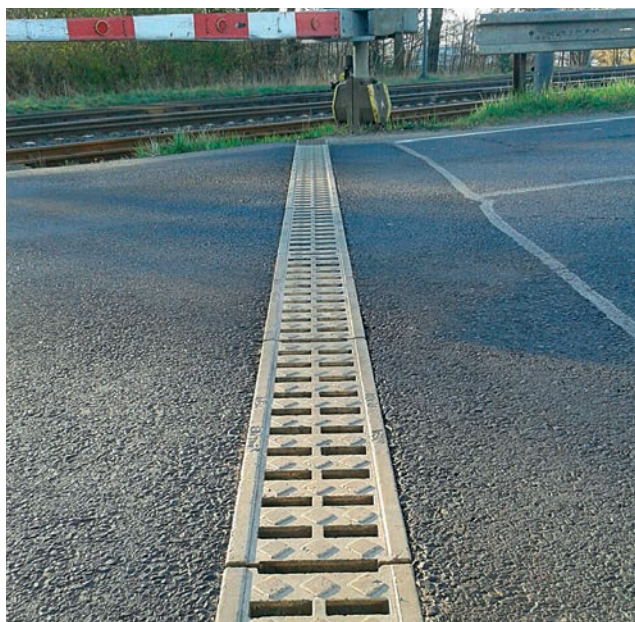
Polymerický žlab pro příčné křížení komunikací u železničních přejezdů
