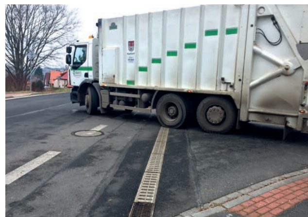
Polymerický žlab pro zátěž D400 až F900 kN
